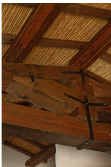
Figura 15 - Dettaglio Capriata legno
