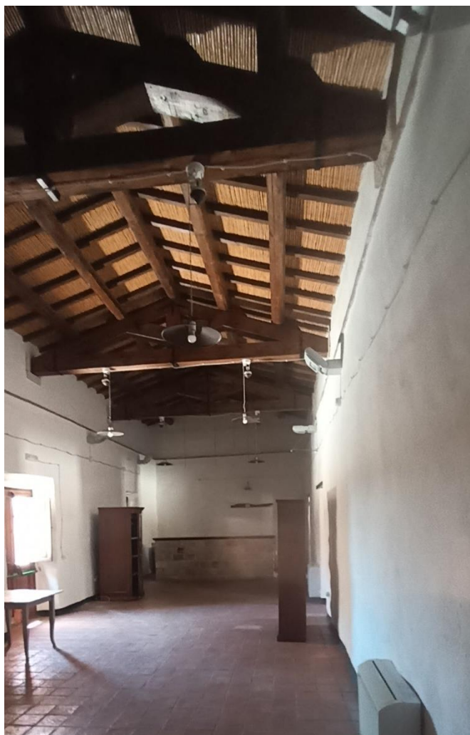
Figura 14 - Sala ristorante e copertura canniciato
