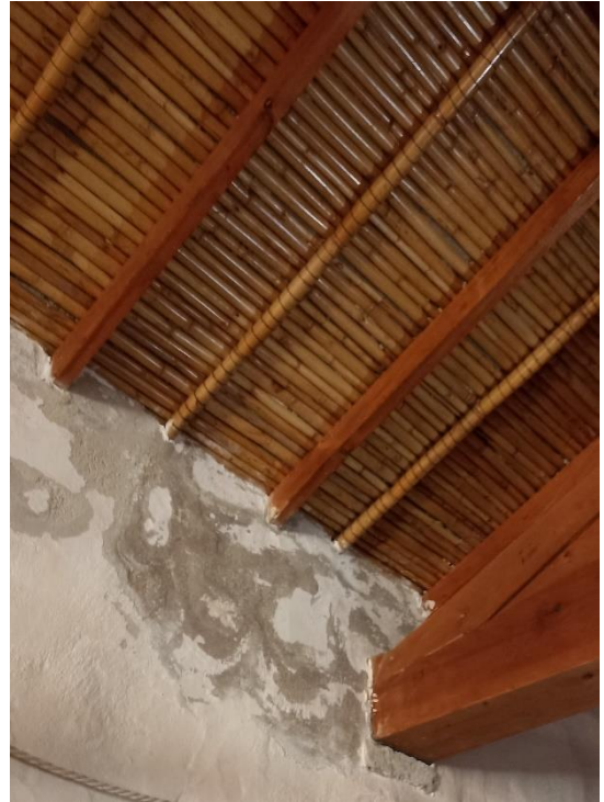
Figura 12- Dettaglio cannicciato
