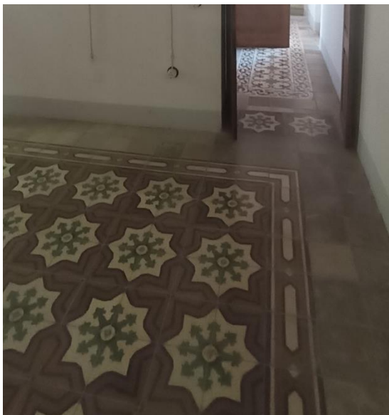
Figura 9 - Dettaglio pavimentazione recuperata
