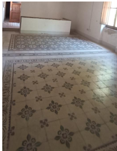
Figura 10 - Particolare pavimento Primo piano
