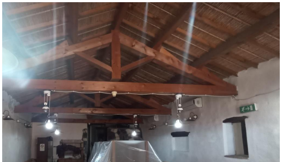
Figura 6 - Particolare sala principale
