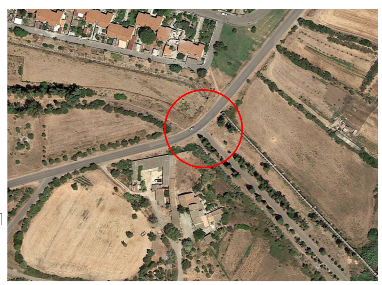
VISTA GENERALE CON AREA DI INTERVENTO
